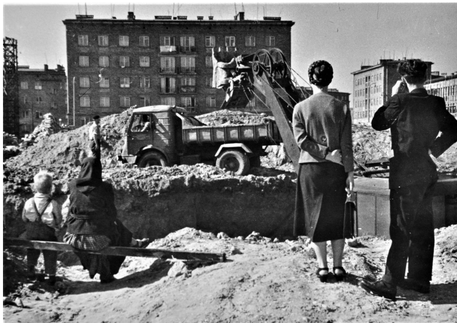
Fot. 1. Nowa Huta koło Krakowa w budowie, ok. 1955 r., fot. Wiesław Tomaszkiwicz, Muzeum Fotografii w Krakowie - MuFo, sygn. MHF 21405/II
