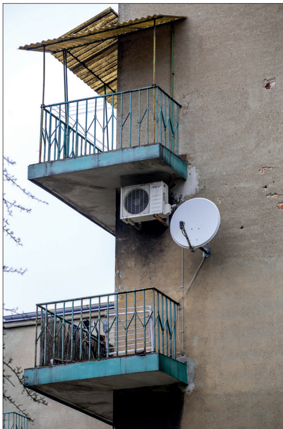
Fot. 6. Balkonowy daszek, klimatyzator i antena satelitarna, które mieszkańcy umieścili na jednym z bloków, przystosowując zabytkową architekturę do potrzeb współczesnego życia, grudzień 2021. Fot. Sebastian Nowakowski.
