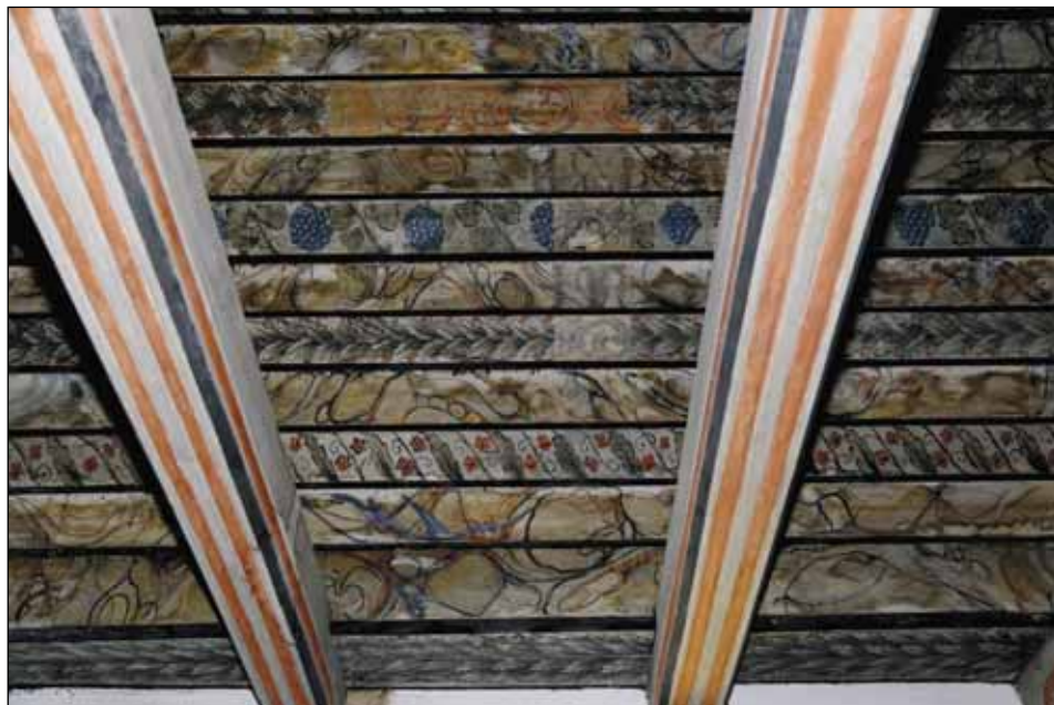
Ryc. 11. Chlastawa, dawny zbór graniczny, obecnie kościół filialny pw. Narodzenia NMPanny, dekoracja malarska przykrycia aneksu południowego, projekt Max Kutschmann, ok. 1910 r. Fot. A. Jankowski
