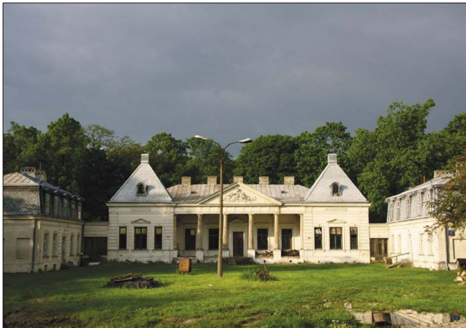
Ryc. 13. Pałac w Młocinach z oficynami pierwszymi, widok od południa, w obrębie dziedzińca, fotografia z 2010 r. (fot. W. Bis)
