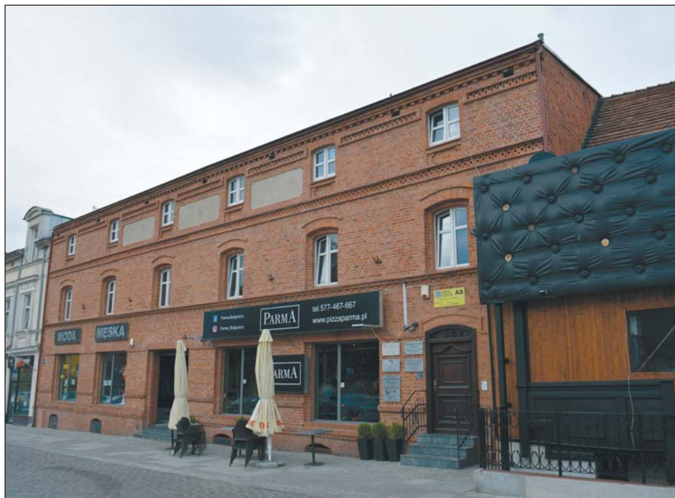
Ryc. 10. Zabudowa pofabryczna dawnej Polskiej Fabryki Tytoniu Juliana Króla przy obecnej ul. Długiej 63 (fot. A. Wysocka, 2021 r.)
