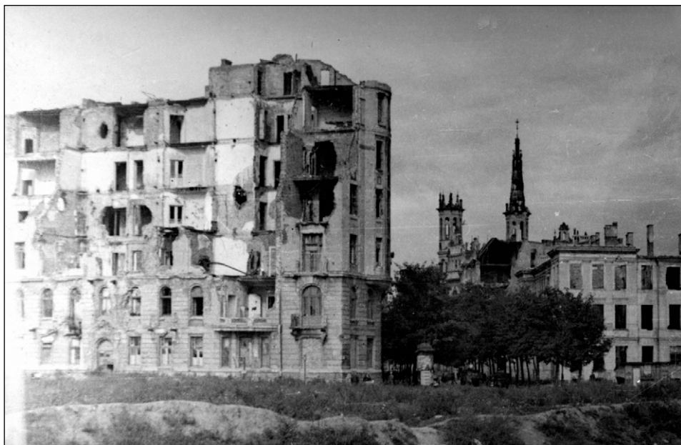
Ryc. 9. Kamienica przy ul. Polnej 32 (26), widok od strony ul. Polnej, stan latem 1946 r. Fot. Aleksander Leszczyński. Źródło: AP Warszawa, AFWAL, sygn. 289
