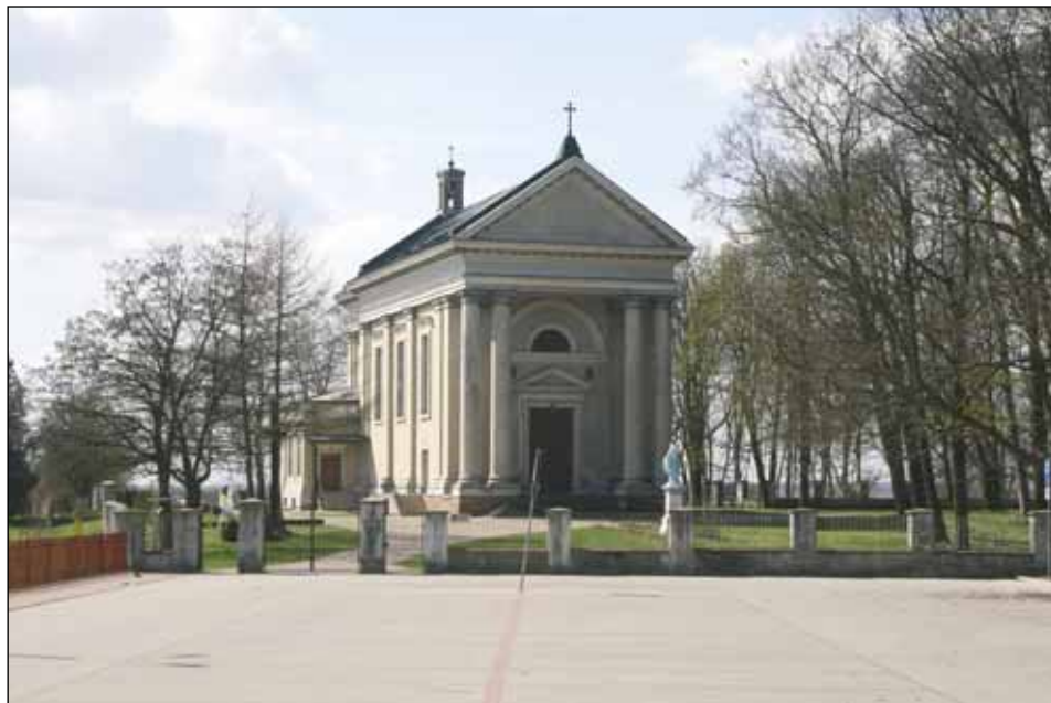
Ryc. 8. Kościół fundacji Róży z Potockich Krasieńskiej z lat siedemdziesiątych XIX w., który zastąpił rotundę. Kaplica grobowa Krasieńskich rozciąga się pod całą długością kościoła, stanowiąc z kościołem jedną bryłę. Fot. W.J. Górczyk
