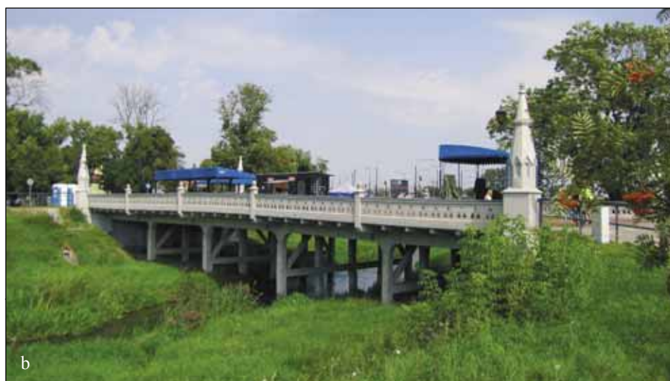
Ryc. 2. Most nad rzeką Bystrzycą w ciągu ul. Zamojskiej, wybudowany w 1909 r. a — pocztówka z lat 1914–1918 ze zbiorów Zbigniewa Nestorowicza, b — stan obecny po renowacji. Fot. J. Żywicki, 2016
