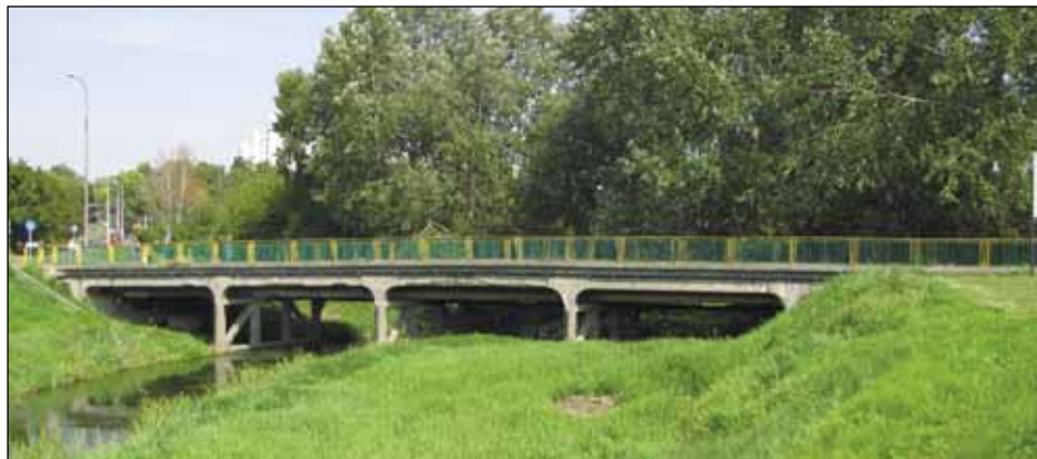
Ryc. 1. Most nad rzeką Bystrzycą (pomiędzy al. Andersa a ul. Turystyczną), wybudowany w 1908 roku. Fot. J. Żywicki, 2016
