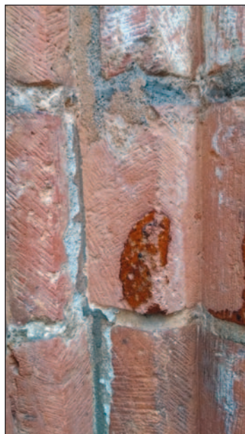
Ryc. 9. Sandomierz. Cegły zdobione ukośnymi nacięciami i szklivem w północnym portalu kościoła św. Jakuba (fot. M. Błoński)
