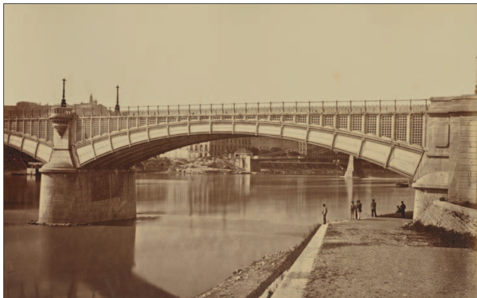
Ryc. 1. Wiadukt nad Rodanem w Lyonie (z albumu Chemins de Fer de Paris à Lyon et à La Méditerranée ), fot. Édouard Baldus, ok. 1861 (The J. Paul Getty Museum, nr inw. 84.XO.734.1.7)
