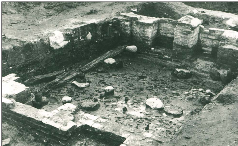
Ryc. 5. Wykop 8. Fragment kamienicy sieniowej z charakterystycznymi wnekami w grubości murów. Fot. A. Kaube; APA Wolin, sygn. 3345
