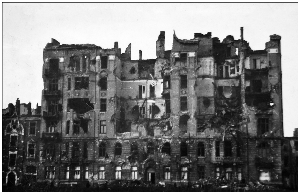
Ryc. 8. Kamienica przy ul. Polnej 32 (26), widok od strony ul. Polnej, stan w drugiej połowie roku 1945. Fot. Jan Kazimierz Siudecki. Źródło: Kroniki. 2024
