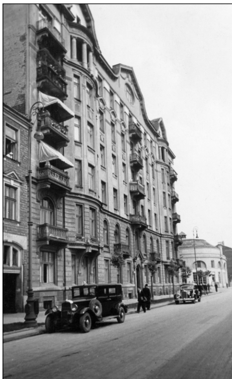
Ryc. 7. Budynek przy ul. Polnej 26 (32) w Warszawie, widok fasady od ul. Polnej, stan na dzień 5 czerwca 1938 r.
