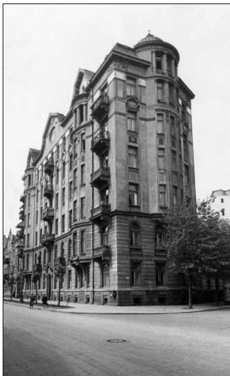
Ryc. 6. Kamienica przy ul. Polnej 26 (32) w Warszawie, widok od strony narożnika, stan na dzień 5 czerwca 1938 r.
