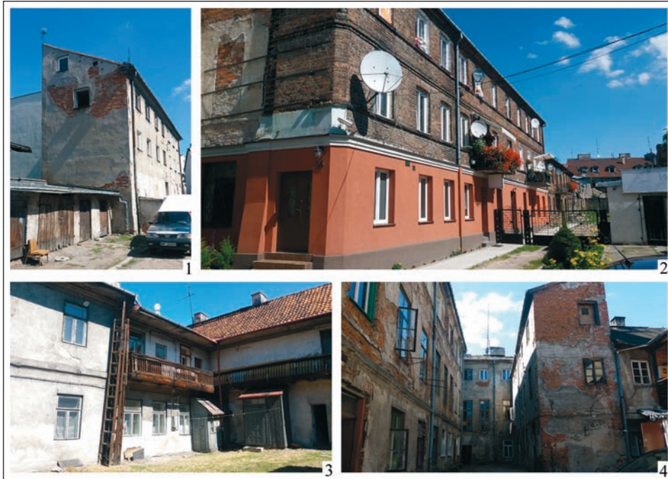
Ryc. 13. Płock — przykłady zachowanych oficyn na posesjach w obrębie dawnej dzielnicy żydowskiej, stan z 2017 r.: 1 — ul. Kwiatka 34; 2 — ul. Kwiatka 16; 3 — ul. Grodzka 5; 4 — ul. Synagogałna 5. Fot. M. Bis
