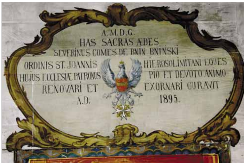
Ryc. 3. Gułtowy, kościół parafialny pw. św. Kazimierza; inskrypcja nad portalem zakrystii. Fot. A. Jankowski
