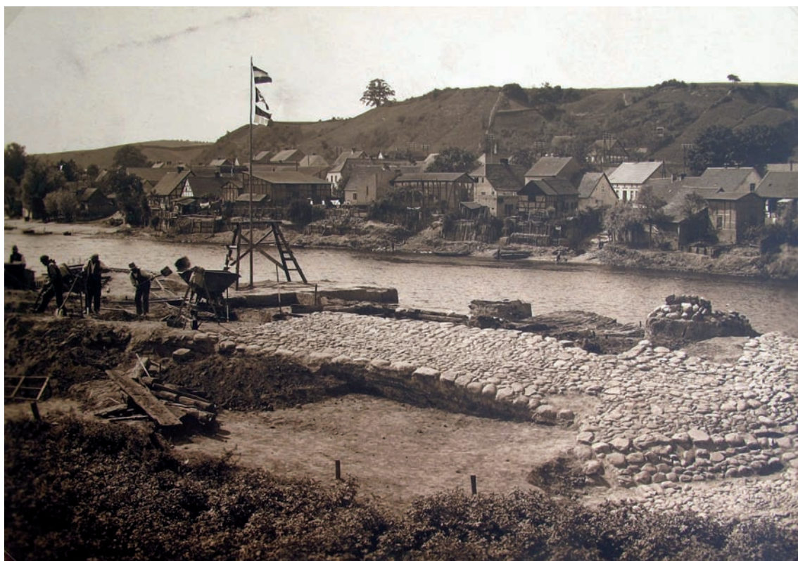
Ryc. 12. Zdjęcie wykonane w latach 30. XX wieku, w trakcie prac archeologicznych prowadzonych na terenie grodziska znajdującego się naprzeciwko Santoka. Uwagę zwraca relatywnie dobrze zachowana konstrukcja kamienna. Uważny widz zwróci również uwagę na flagi powiewająca nad wykopaliskami realizowanymi przez obywateli III Rzeszy i członków NSDAP (fotografia ze zbiorów Centralnego Archiwum Archeologicznego w Berlinie, prawa autorskie: Staatliche Museen Berlin. Museum für Vor- und Frühgeschichte)
