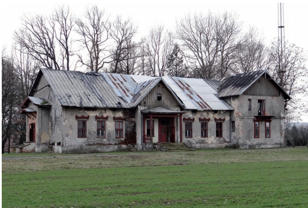
Ryc. 15. Dwór w Przybysławicach, pow. Miechów. 2016 r. Fot. Domena publiczna Fig. 15. The manor house in Przybysławice, Miechów district, 2016. Photo from public domain
